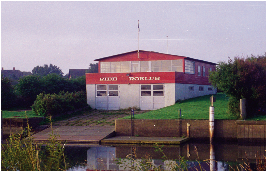
Klubhuset i 2001, umiddelbart inden nedrivning. Foto: Jens Bruun-Petersen.
