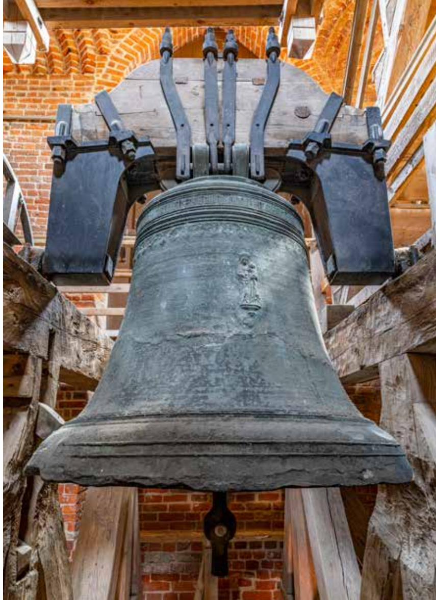
Domkirkens gamle kirkeklokke, Mariaklokken, med Jomfru Maria med Jesusbarnet afbildet på den del af klokken, der kaldes legemet. Klokken er senest 1929 ophængt i en vuggebom, som hæver sig over selve ophængets aksler. Herved får klokken en vis kontravægt, som gør svingningen mere skånsom både for klokke og for ophænget. Det giver desværre også en svagere klang.
