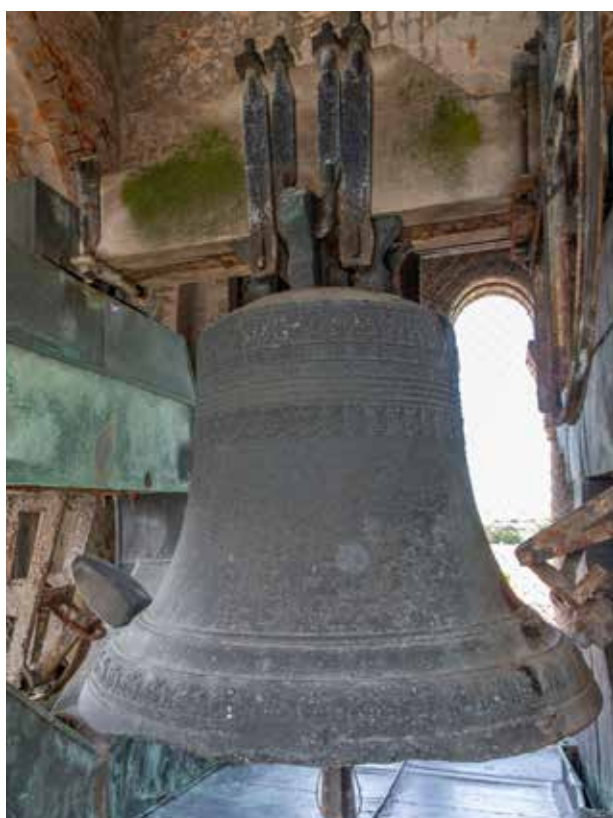
De to spirkløkker med den såkaldte 'Skoleklokke' i forgrunden. På den ses Christian VII's monogram, og på slagringen nederst læses „ME FECIT IOH: NIC: BIEBER IN HAMBURG 1770“ (Mig gjorde Joh. Nicolaus Bieber [etc.]). Dens mekaniske ringeanlæg ses tydeligt, mens den anden klokke kræver manuel betjening. Det sker sjældent!
