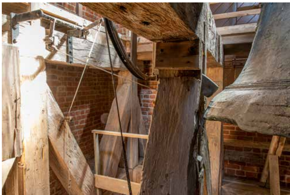
Foruden at svinge ved sidste gudstjenesteringning udløses bedeslag og urets kvarterslag 1–4 af Mariaklokkens mekaniske hammer.
